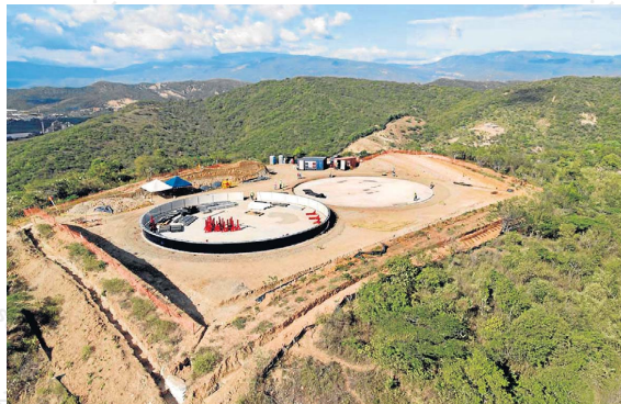
Así avanza la obra de los 'megatanques' que se ubicarán en el sector de Cumbres Bajas, en el municipio de Los Patios. Foto: suministrada
